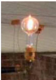
Il acheta une pompe à vide puis il demanda à son souffleur de verre de fabriquer une ampoule en forme de poire. Il y installa un filament de platine, son ami JELH pompa l'air puis le souffleur de verre scella l'ampoule.
